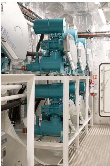
Bilde 3 låsere uten lydisolerende metallskap
