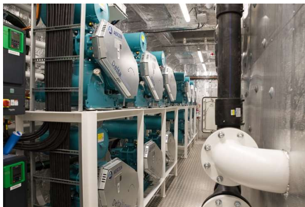
Bilde 2 Blåsere uten lydisolerende metallskap
